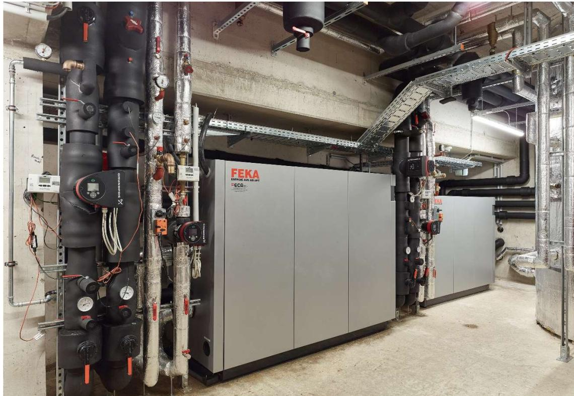
**Abluft-Wärmepumpe + Abwasser-Wärmepumpe**
